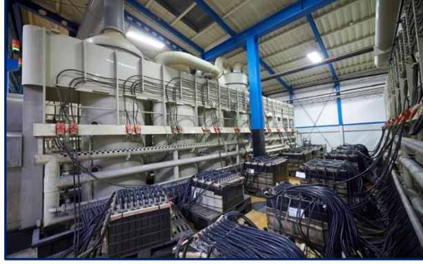
Şekil - 67. Akülerin Şarj Edilmesi
