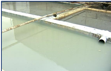
Şekil - 90. Asitli Suyun Arıtımı
